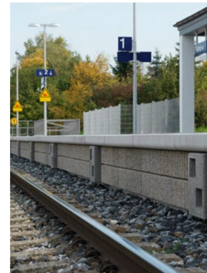
Hochabsorbierende Bahnsteigkante, Bahnhof Töging (Inn), DE
