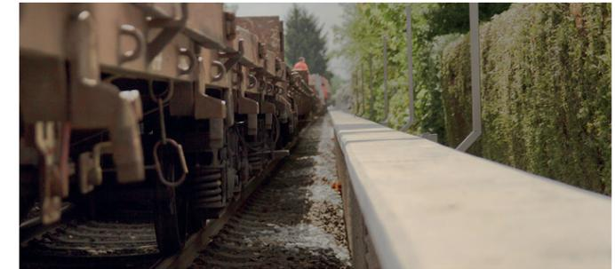
Die niedrige Wand wird nah am Gleis errichtet und eignet sich daher für Sanierungen von bestehenden Bahnstrecken mit engen Platzverhältnissen.
